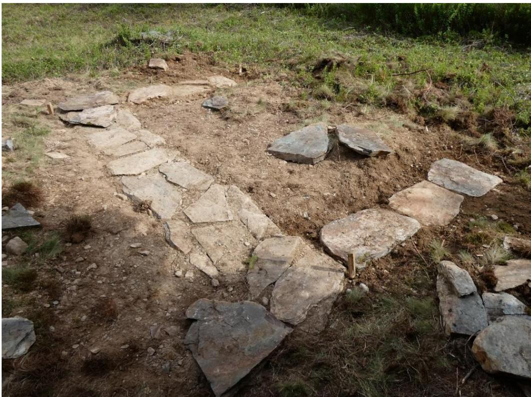
Foto 4: Steinfundament für einen Werkzeug Schuppen. (Neufundland, August 2023)
